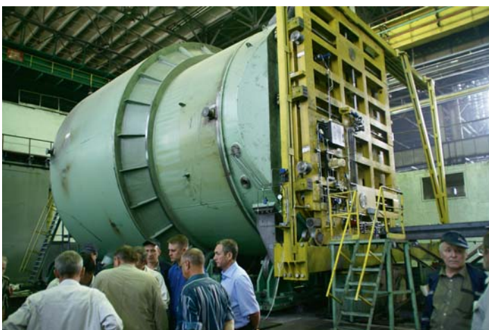
Изготовление шлюза для АЭС «Куданкулам» на «Ижорских заводах»
